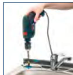
5. В выбранном Вами месте для крана чистой воды просверлите отверстие диаметром 12 мм
