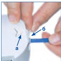
**12.** Свободный конец трубки с запрессованной латунной втулкой вставьте в фильтр, ориентируясь на стрелку (а) «выход». Закрепите обе проводящие трубки стопорными клипсами (б)
